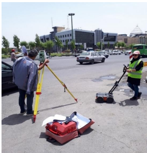
شکل ۱۰-۴- پروژه ژئورادار در محدوده خیابان سی متری جی واقع در شهر تهران.
