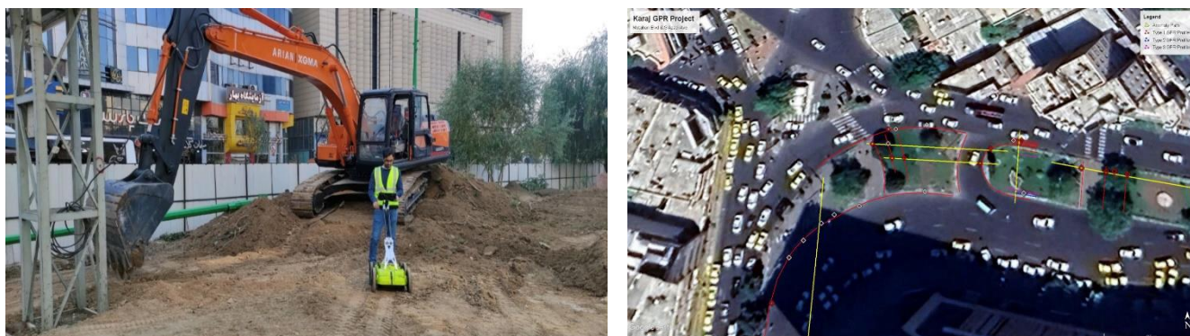
شکل ۴-۱۴- پروژه احداث تونل در شهر کرج.
