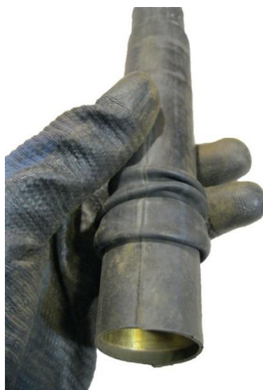
شکل ۶-۱۰: تیوپ لبه گیری شده در حال نصب
